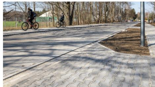
Przebudowa ul. Rekreacyjnej w Granicy
