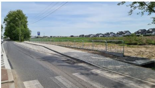
Zatoka autobusowa w Pęcicach
