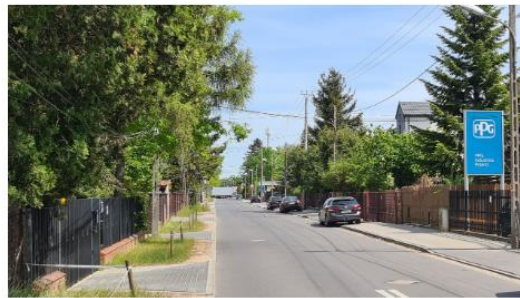
Przebudowana ul. Bodycha w Opaczy-Kolonii
