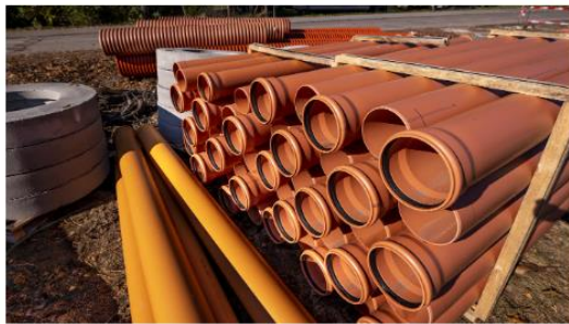
Budowa kanalizacji na ul. Rekreacyjnej w Granicy
