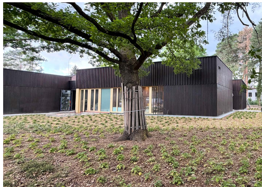
Budowa Centrum Inicjatyw Kulturalnych w Komorowie
