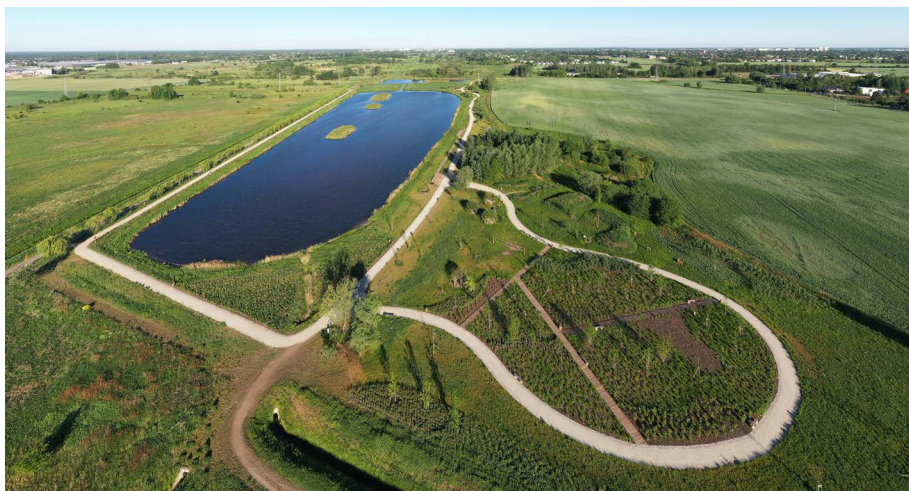
Zbiorniki retencyjne w Michałowicach.
