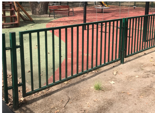
rys. 15 Zdjęcie poglądowe ogrodzenia
