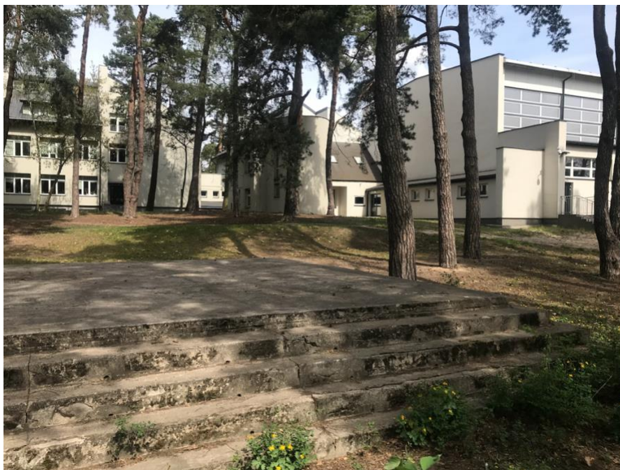
Rys. 1. Stan aktualny zagospodarowania - wizja lokalna kwiecień 2020 r.
