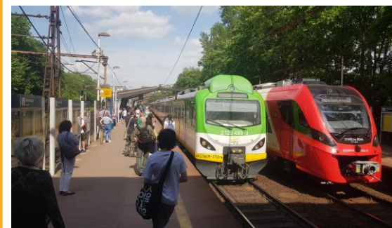
Rys. 2.7 Infrastruktura kolejowa PKP Powiśle w Warszawie
