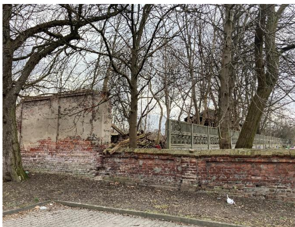
Ryc. 10 Pozostałości zabudowy na południe od cmentarza; źródło: fotografia własna z dn. 07.03.2024 r.
