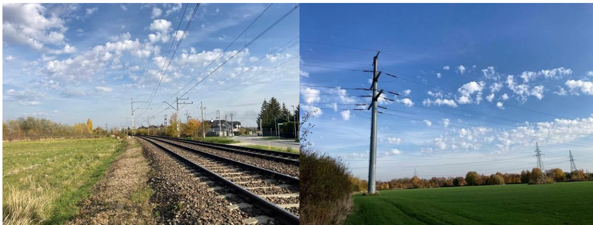
Nasyp kolejowy linii WKD – fot. własna
