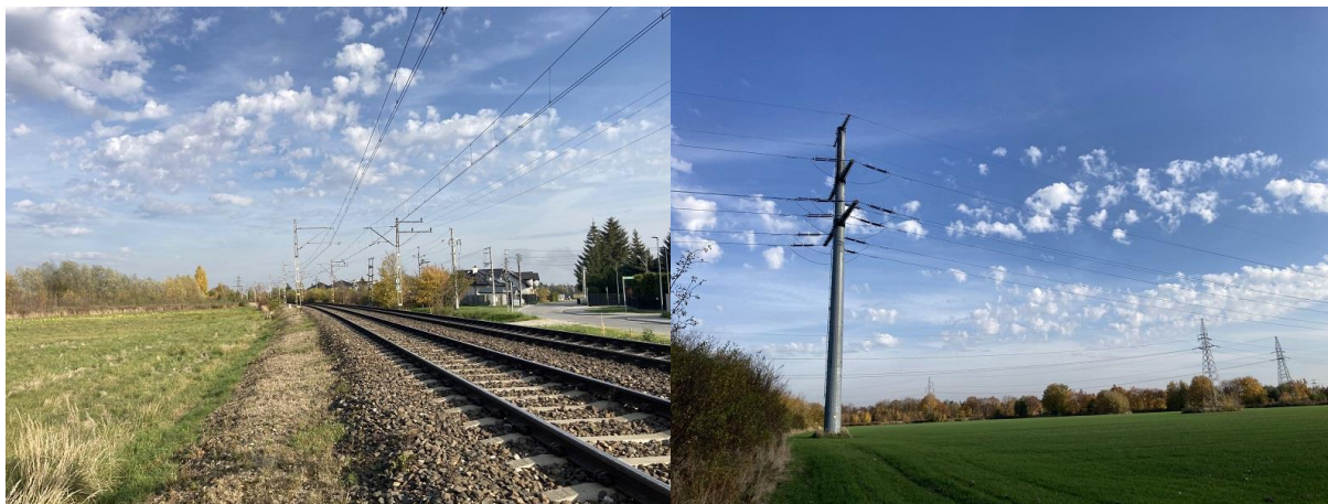
Nasyp kolejowy linii WKD – fot. własna
