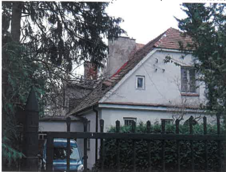
zdjęcie wykonane w kierunku wschodnim (data: 20.11.2020 r.)
