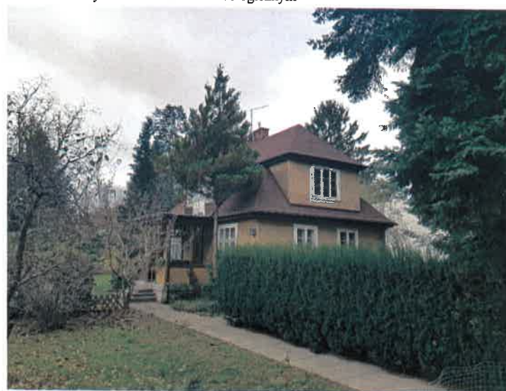
zdjęcie wykonane w kierunku wschodnim (data: 20.11.2020 r.)
