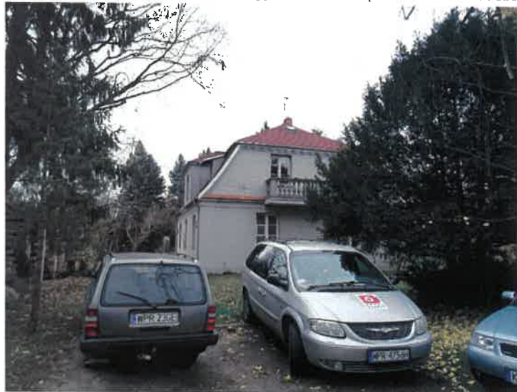
zdjęcie wykonane w kierunku wschodnim (data: 20.11.2020 r.)
