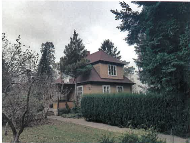
zdjęcie wykonane w kierunku wschodnim (data: 20.11.2020 r.)
