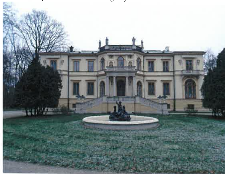
zdjęcie wykonane w kierunku wschodnim (data: 02.12.2020 r.)
