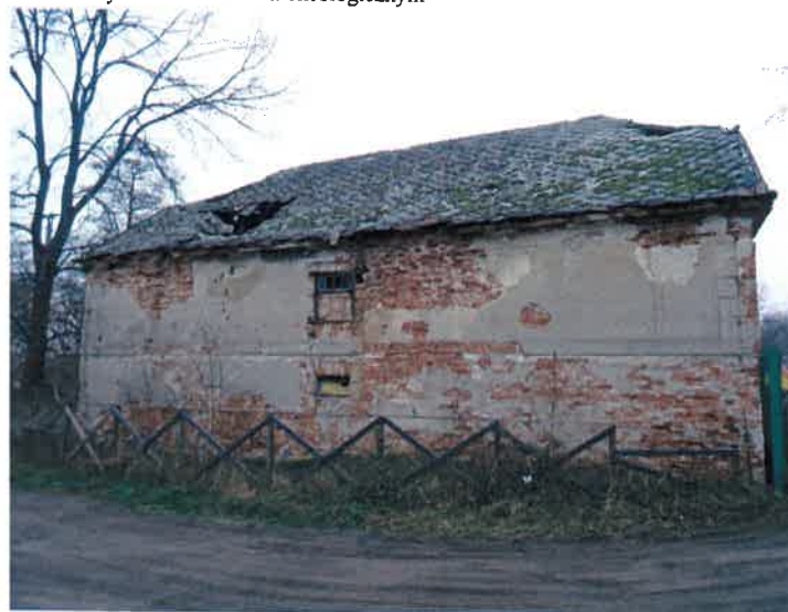
zdjęcie wykonane w kierunku wschodnim (data: 20.11.2020 r.)
