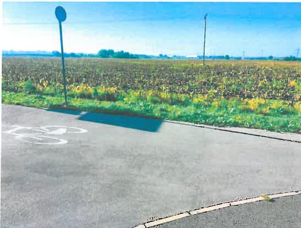
Michałowice - budowa ścieżki w al. Topolowej od ul. Szkolnej do ul. Kolejowej
