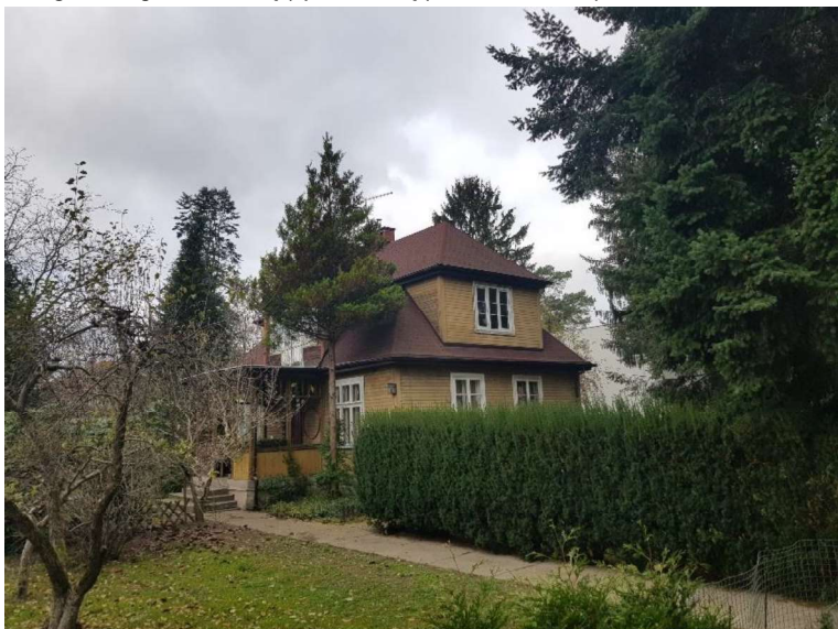
zdjęcie wykonane w kierunku wschodnim (data: 20.11.2020 r.)
