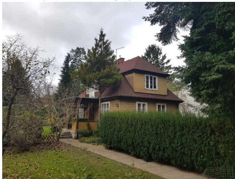
zdjęcie wykonane w kierunku wschodnim (data: 20.11.2020 r.)
