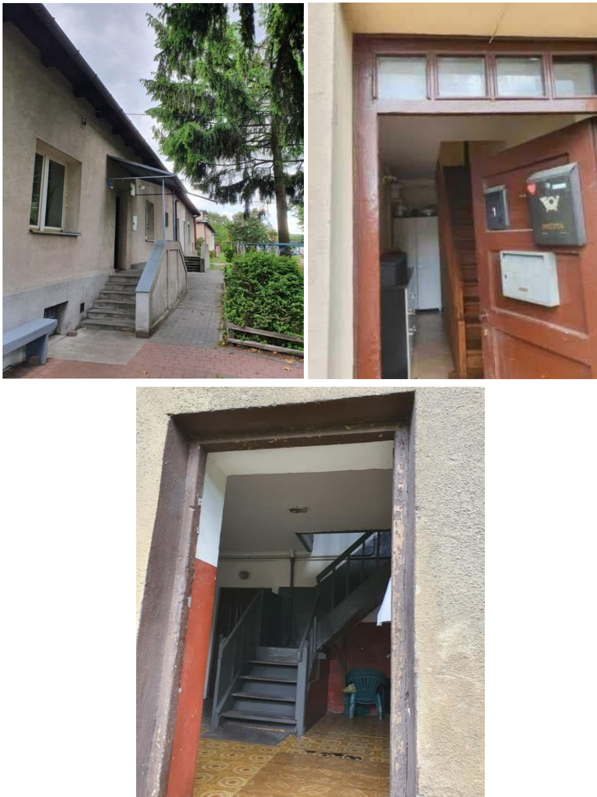
Zdjęcie 14 Wymagająca działań remontowych zabudowa mieszkaniowa w Regułach
