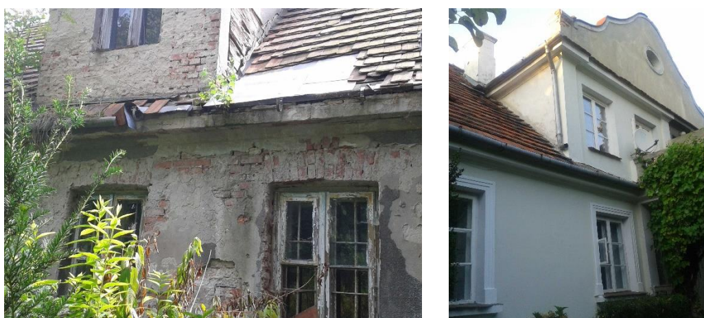
Rysunek 25 Zabytkowe budynki mieszkalne położone na Osiedlu Komorów przy ul. Lipowej
